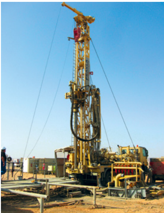
RB 50 bei der Ölschiefererkundung RB 50 exploring for oil shale
