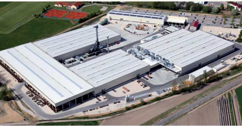
Edelshausen plant of BAUER Maschinen GmbH
