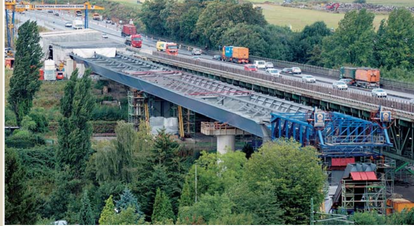
Schachtbau Nordhausen: Construction of Schnettker bridge
